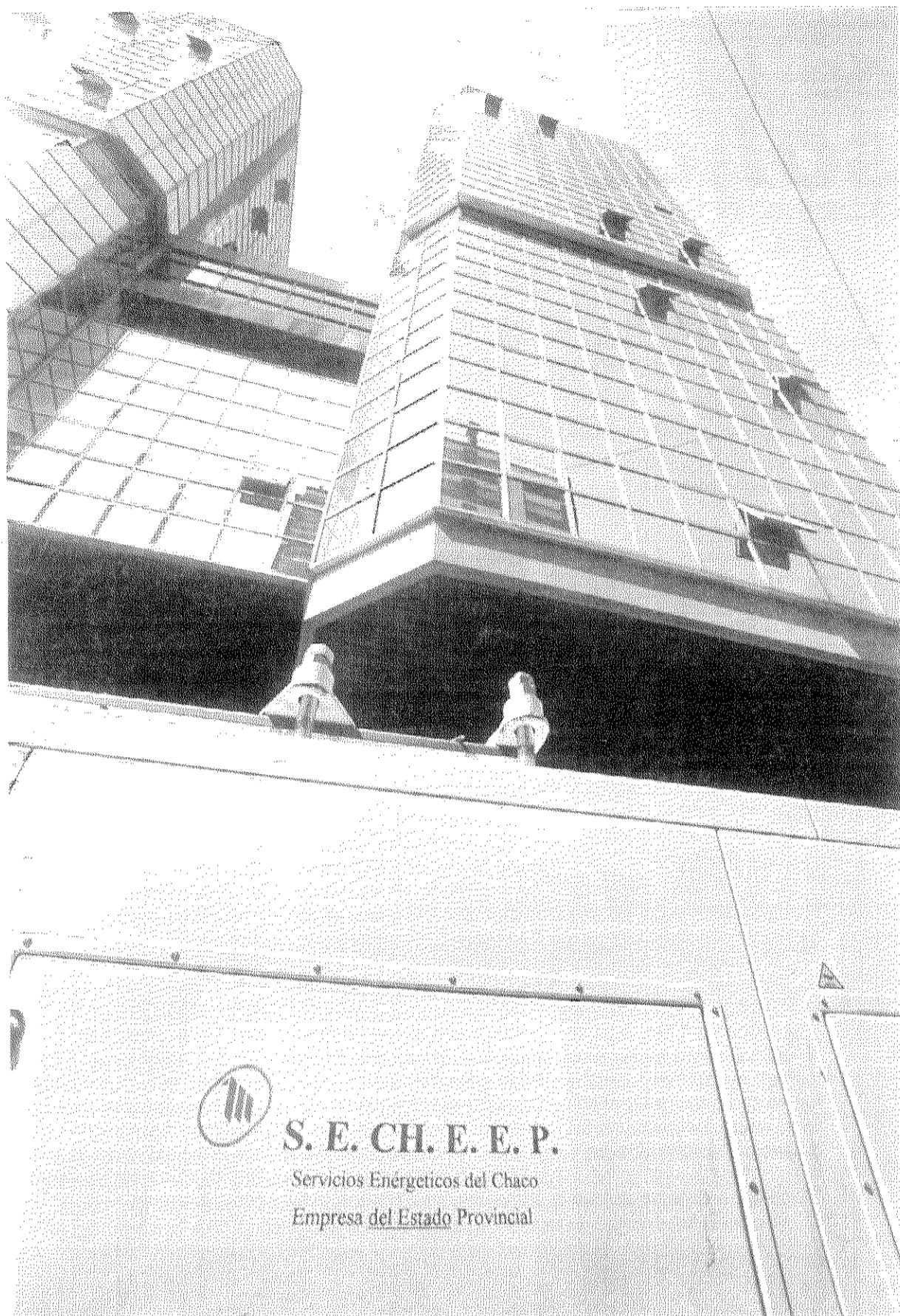
EDESUR recurrió al auxilio de empresas del estado provinciales, como la chaqueña y la cordobesa, para paliar su déficit. Estas aportaron equipos y personal especializado.
